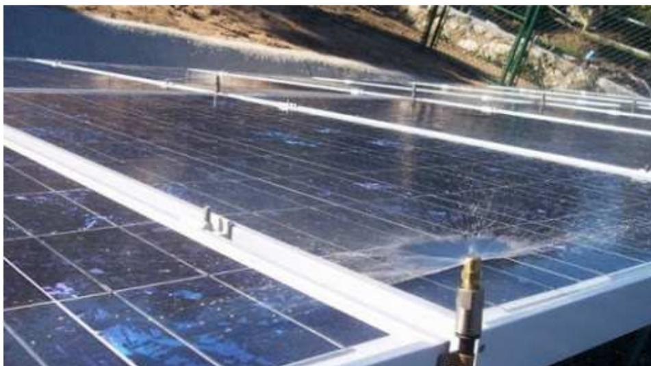
*Ilustración 36: Sistema de auto limpieza automático.*
