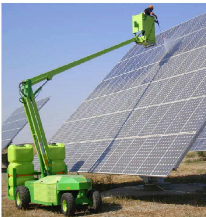
*Ilustración 35: Sistema de limpieza a presión.*
