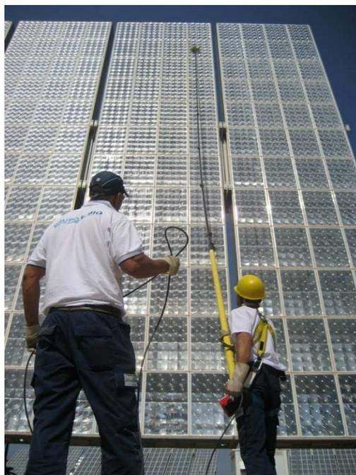
*Ilustración 33: Sistema de limpieza con pértigas.*
