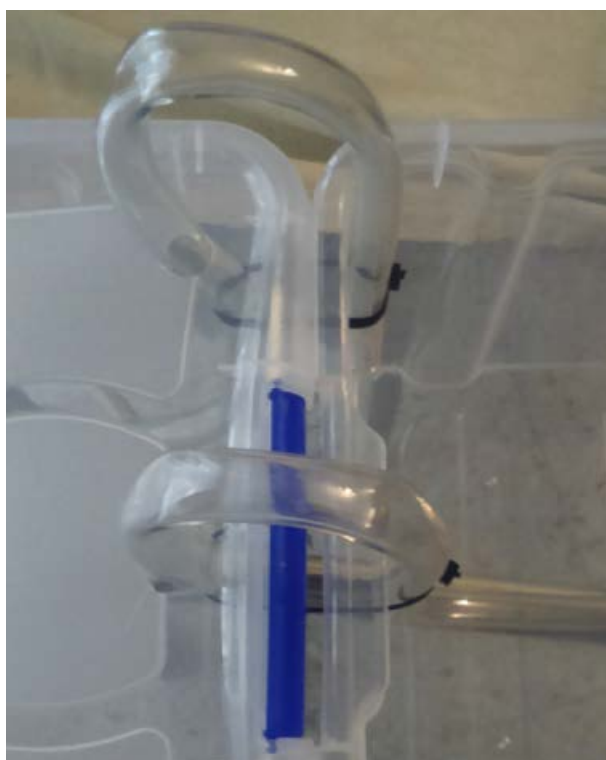
Ilustración 93: Instalación circuito de tuberías de la piscina climatizada.
